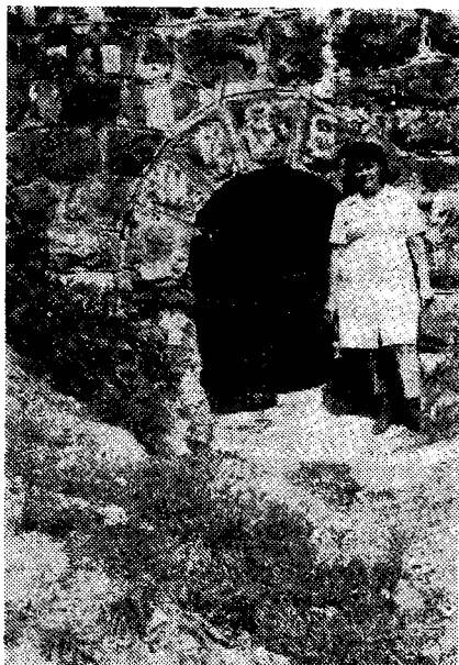
Сл. 1. — Термални „изданачки“ преливни извор „Срдача“ у Витановачкој Бањи. Извор истиче из високог колектора стенске масе дацита у „пропусту“ железничког насипа. Приступ је заштићен жичаном мрежом. Испред каптаже Даница Чурлић, домаћица из Витановца, чијом је иницијативом извориште разгрнуто из камених блокова и бетонски каптирано
