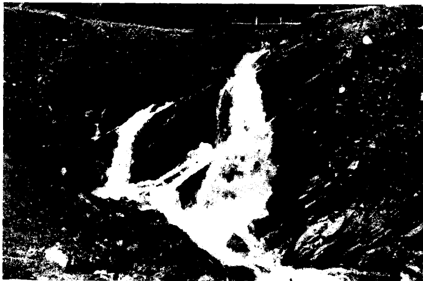
Сл. 3. — Водопад отоке на излазу из канала. С леве стране постављено 5 „анкерисаних“ зидова од габиона (стање на дан 10. VII 1963. год.) 1
